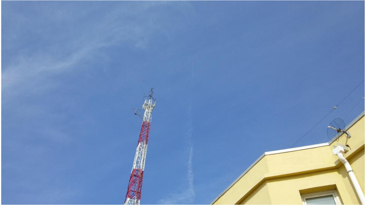
CRC無線電監測站鐵塔天線
