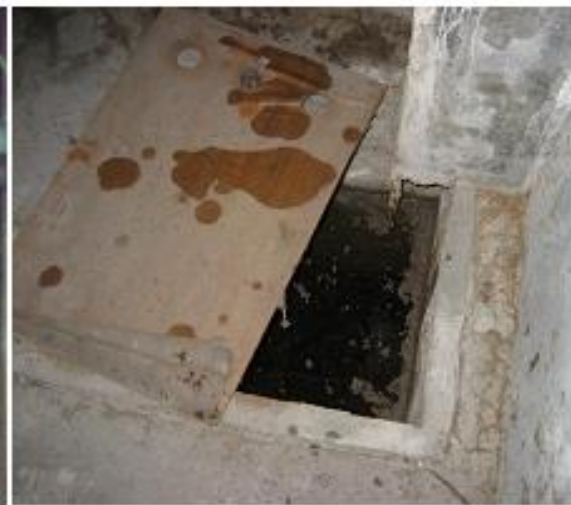
地下室污水池
