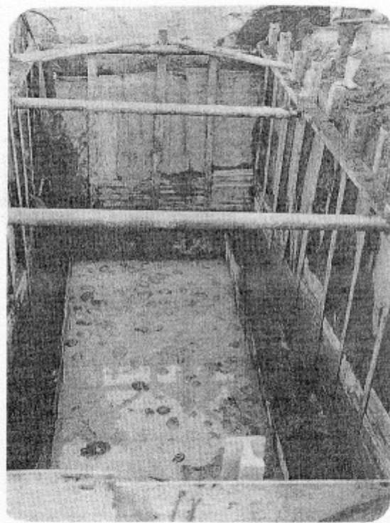
(b) 軟弱地盤時，卵石排置頗為不易，施工前須做好防護措施
