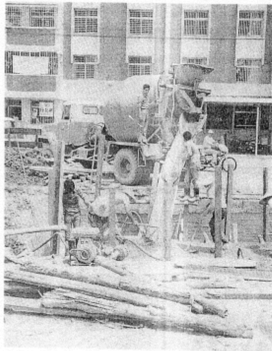
圖16-23 預拌混凝土利用滑槽輸送
