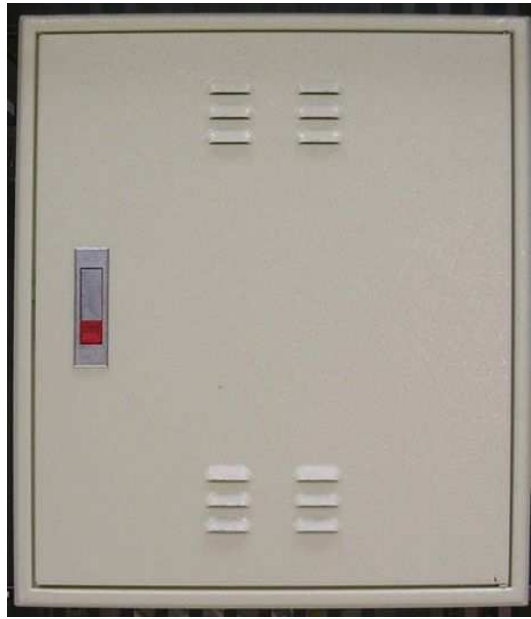
圖12-1 宅內配線箱箱門通風設計示意圖
