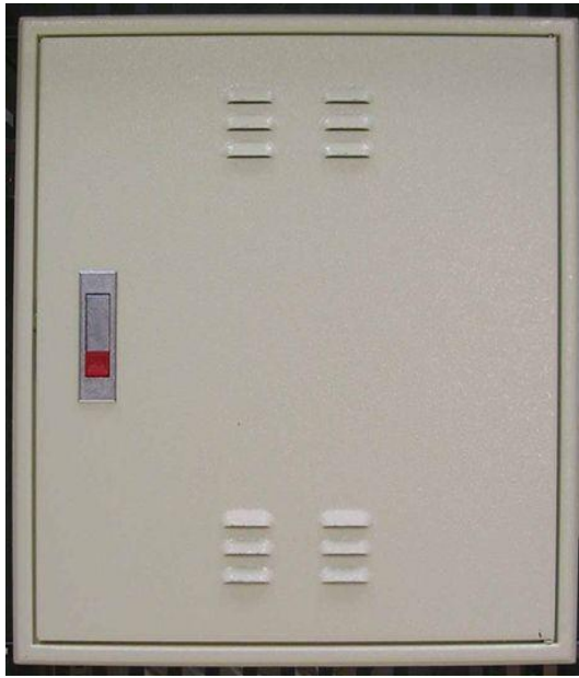
圖12-1 宅內配線箱箱門通風設計示意圖
