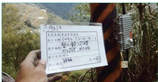
設備：雙向網路放大器 放置地點：梨山幹281桿，H2865，HC04
